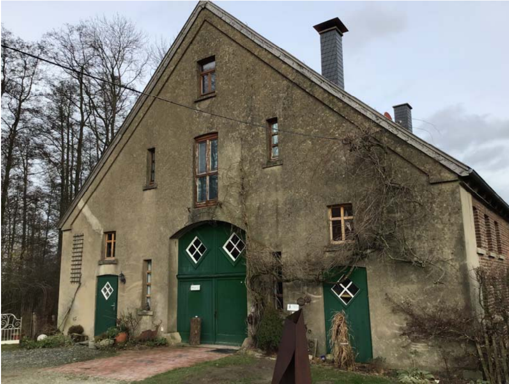
Foto 11: Blick auf die in Richtung Südwesten ausgerichtete Hausfront des Wohnhauses W05
