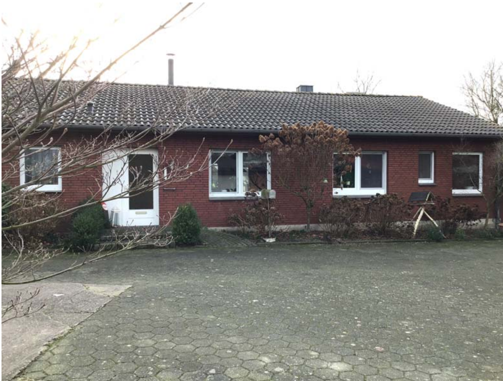
Foto 1: Blick auf die in Richtung Norden ausgerichtete Hausfront des Wohnhauses W01
