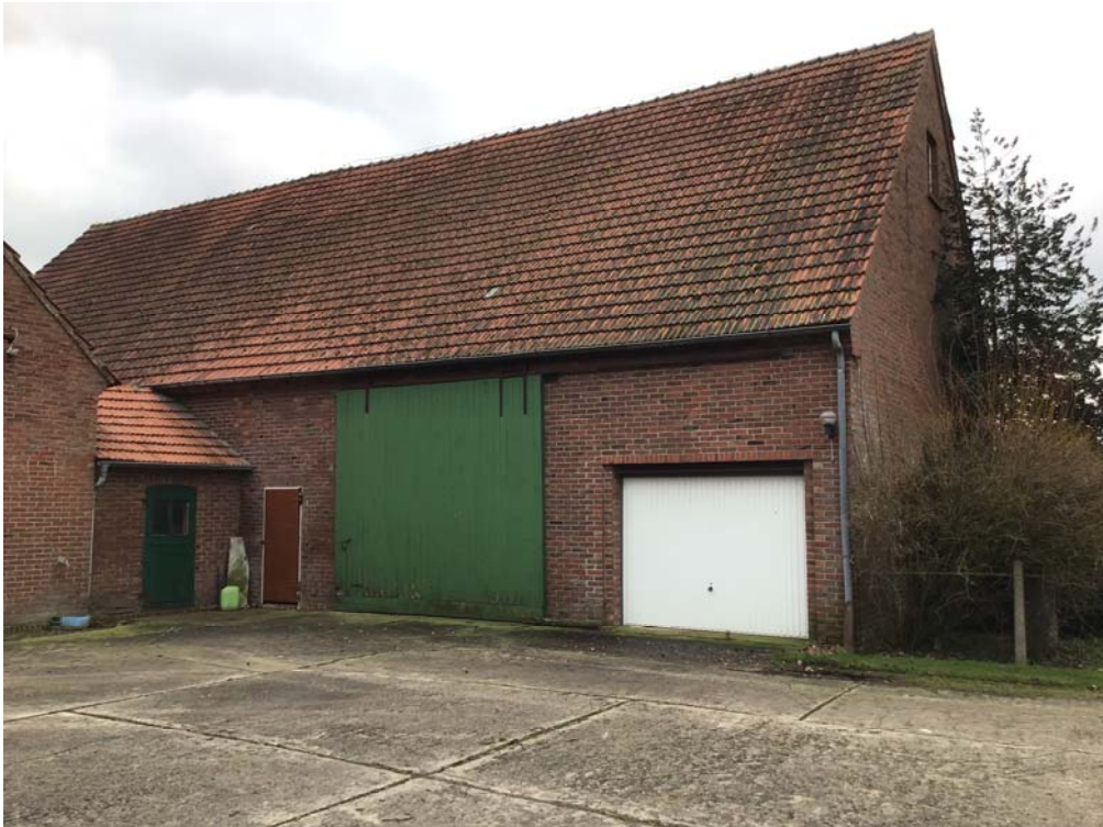
Foto 4: Blick auf die in Richtung Nordosten ausgerichtete Front eines Nebengebäudes ohne Wohnnutzung, dass quer zum dahinterliegenden Wohnhaus W02 steht
