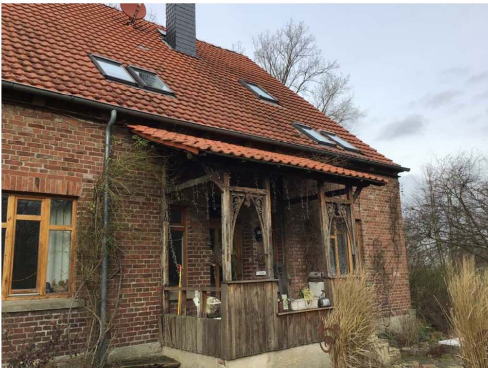
Foto 10: Blick auf die in Richtung Südosten ausgerichtete Hausfront (östlicher Teil) des Wohnhauses W05
